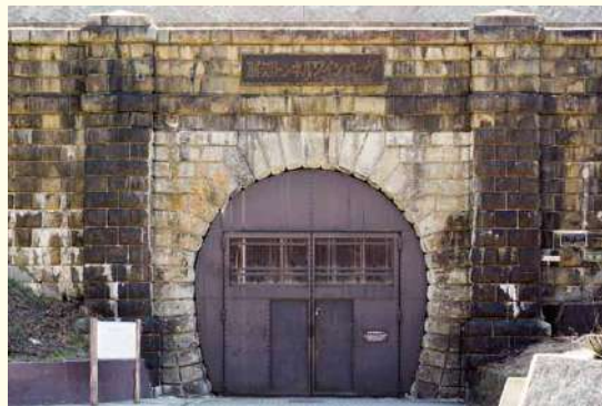
中央線開通時のトンネルのうち、旧深沢トンネルは、現在「勝沼トンネルワインカーブ」として利用されている。レンガ積み全長1,100mのトンネルで、鉄道文化遺産としての価値も高く、ワイン貯蔵庫としては、年間を通じて温度6℃～14℃、湿度45%～60%とワインの長期熟成に最適な環境だと言える。
