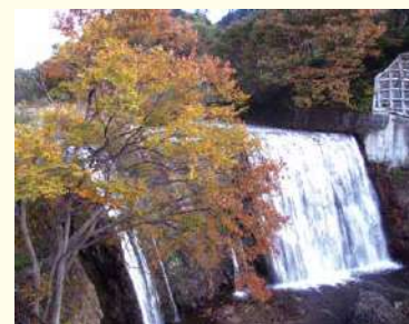
⑧勝沼堰堤
