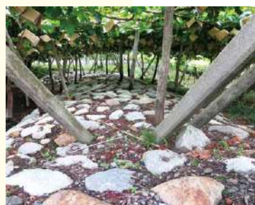
⑨日川治水施設
